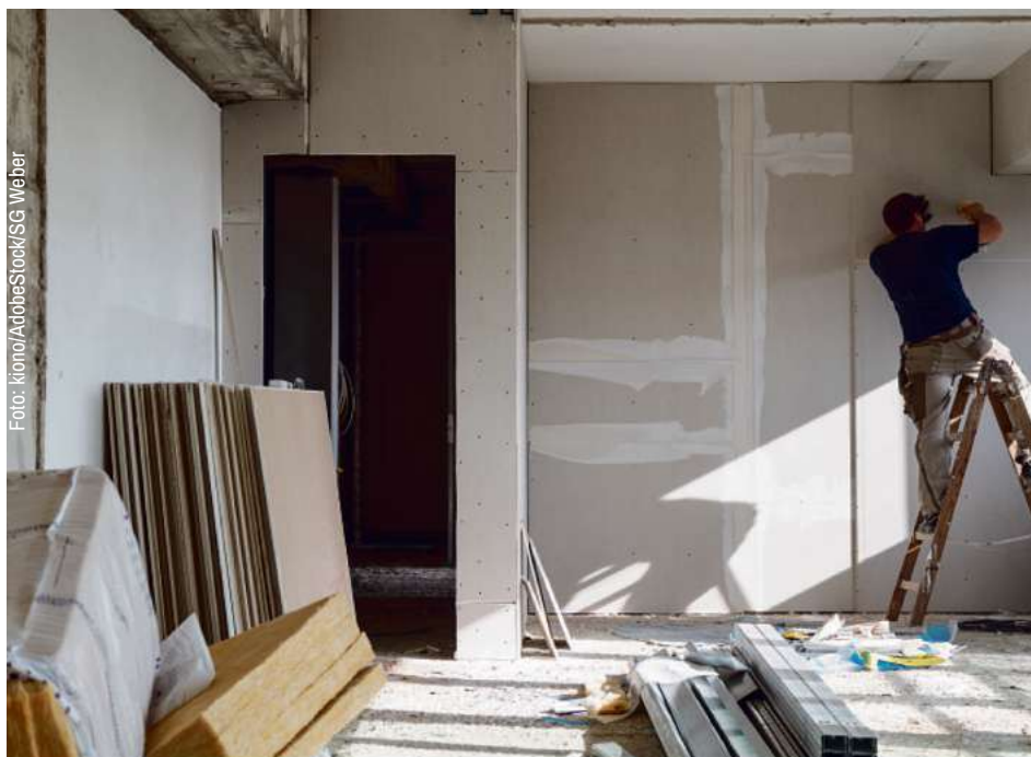
Nach dem Einbau von Trockenbauplatten ist die Wand noch nicht fertig – erst durch das vollflächige Verspachteln entsteht eine glatte, durchgängige Oberfläche.
