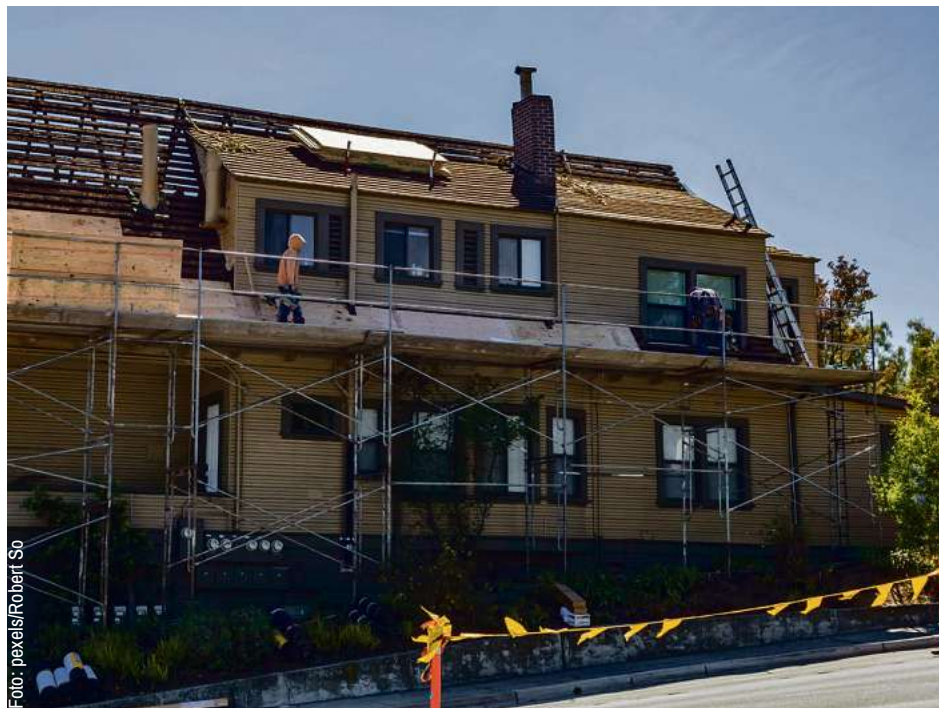
Foto: pexels/Robert So Wer ein Haus baut, sollte frühzeitig an alle notwendigen Versicherungen denken, damit etwaige Unfälle und Schäden nicht zur finanziellen Katastrophe werden.
