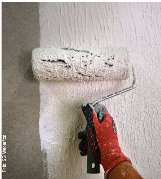
Der Rollspachtel wird mit der Farbwalze aufgetragen – das sorgt für eine gleichmäßige Schichtdicke auf der gesamten Fläche.
